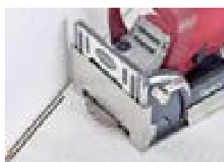
Пиление компенсационных швов
