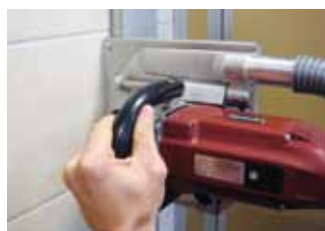
Пропил в стене, отделанной плиткой
