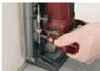
Вырезка компенсационных швов
